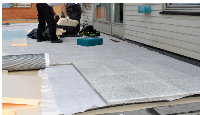
Dremsduk benyttes her som stabiliserende sjikt mellom isolasjon og heller.
