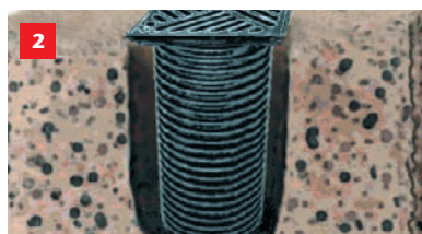
Monter nedsivingssluket.
